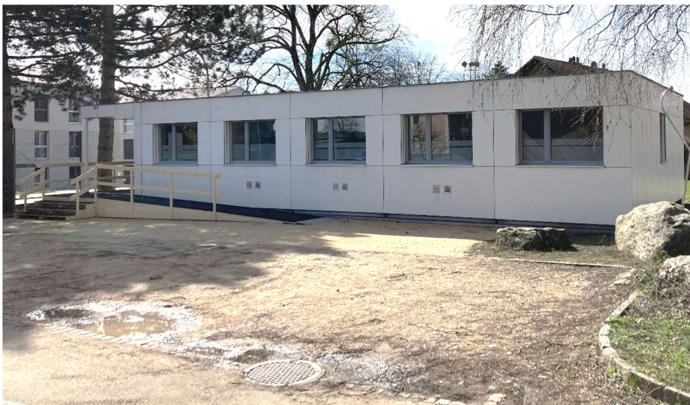
(Büropavillon der Gemeindeverwaltung auf dem Schulhausareal)
